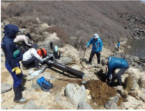
道標交換作業の様子
