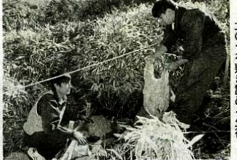
土のうを敷き詰める生徒
