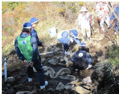
土のうを置いていく
